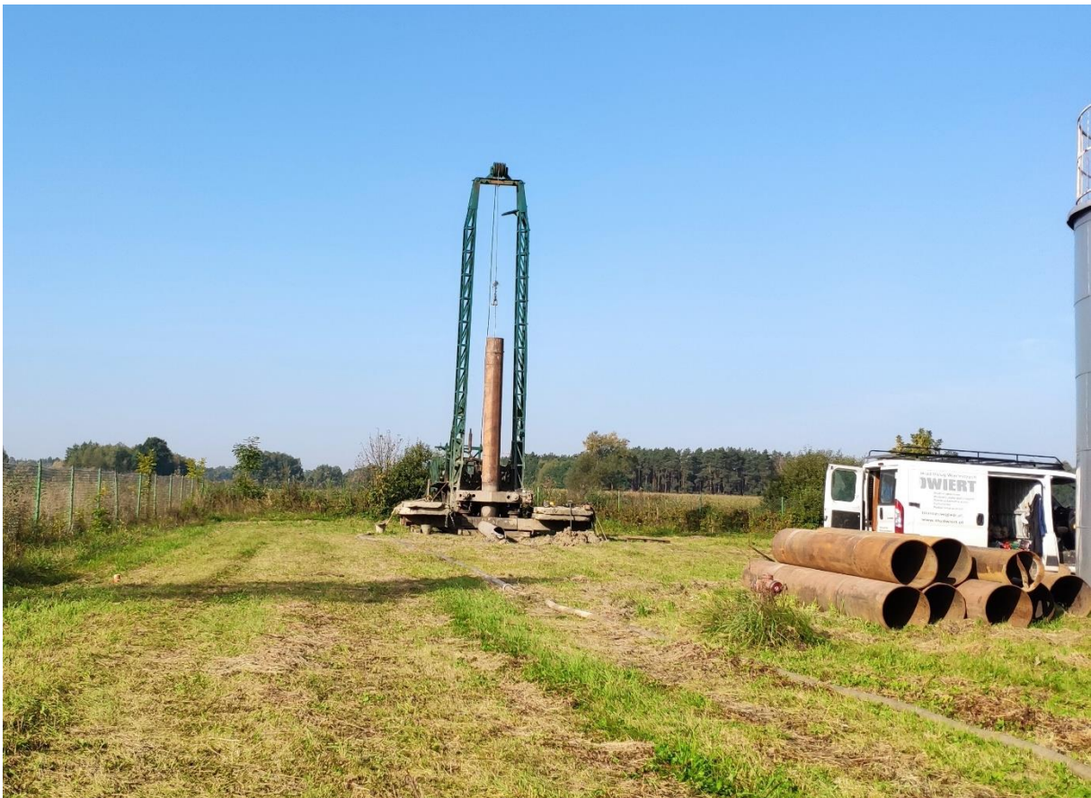
Zdjęcie nr 6: prace przy budowie studni nr 2 w SUW Luberadź (fot. materiały własne).
