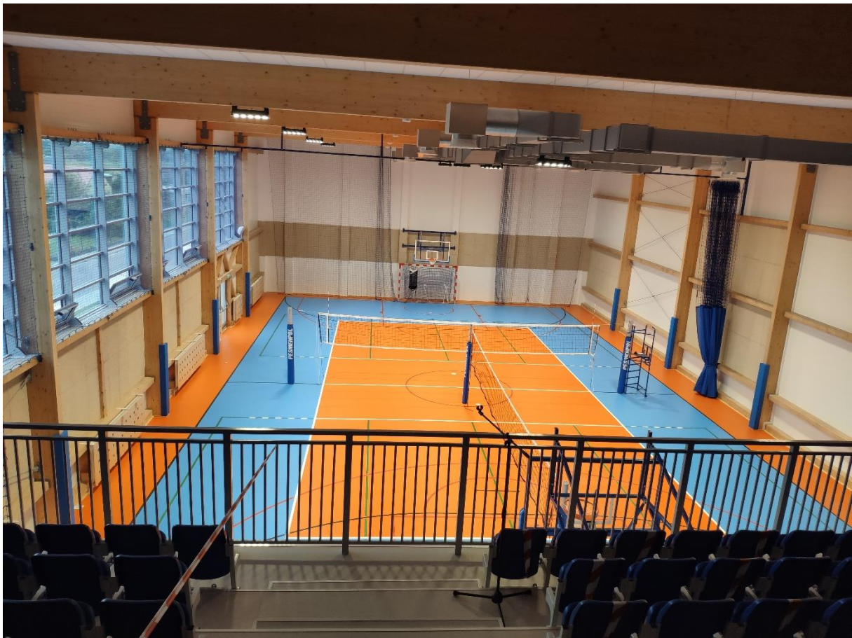
Zdjęcie nr 1 i 2: Budowa hali sportowej Ojrzeniu (fot. materiały własne)
