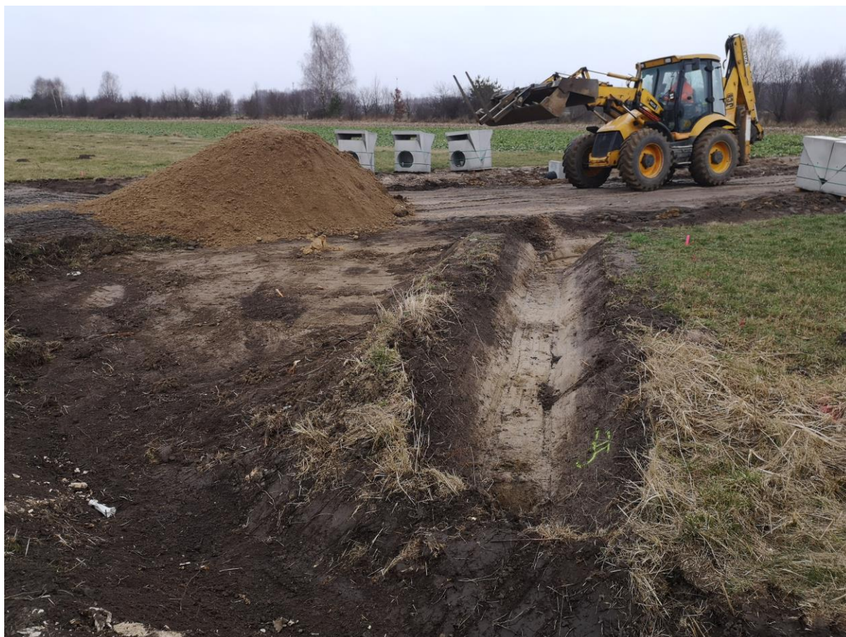
Zdjęcie nr 13 realizacja inwestycji drogowej w Ojrzeniu (fot. materiały własne)
